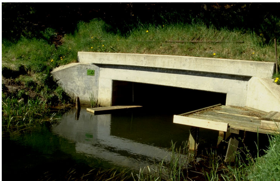
Faunapassage for odder i form af flydende træpontonbro under Hovedvej A 16. Foto: Erling Krabbe, Skov- og Naturstyrelsen.
