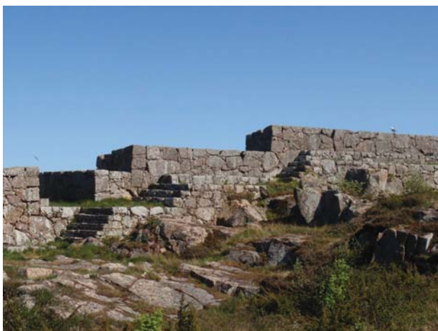
Selve fæstningsværket består af lange murstrækninger opbygget efter tørmurs- og kilestenteknik. Til selve fæstningsværket hører også skyttebænke, trappeanlæg mm.
