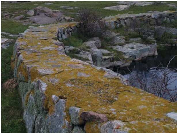
Stensætninger er oftest opbygget med bindemiddel og omkranser dammene.
