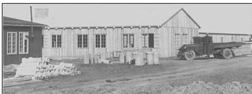
Figur 4: Opførelsen af Almegårds Kaserne, 1947 blev udført af værnepligtige håndværkssvende og lokal arbejdskraft.
