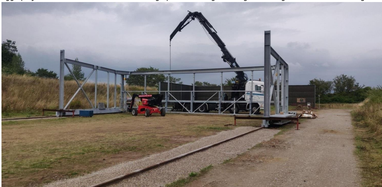
Byggeri af støjdæmpning i form af mobilt skydeskur på Hovnæsbakke Skydebane Foto: Forsvarsministeriets Ejendomsstyrelse
