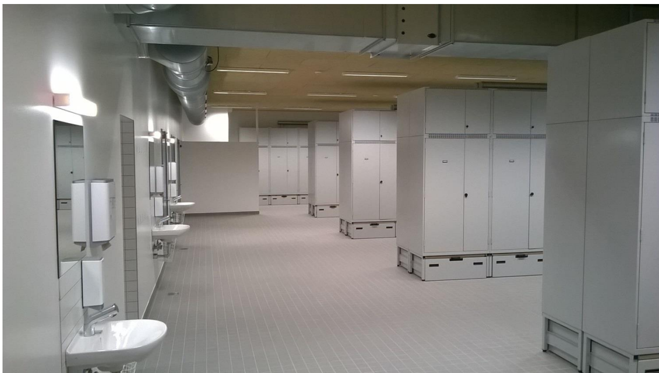
Høvelte Kaserne bygning 305. Omklædning samt opbevaring af udrustning Foto: Forsvarsministeriets Ejendomsstyrelse
