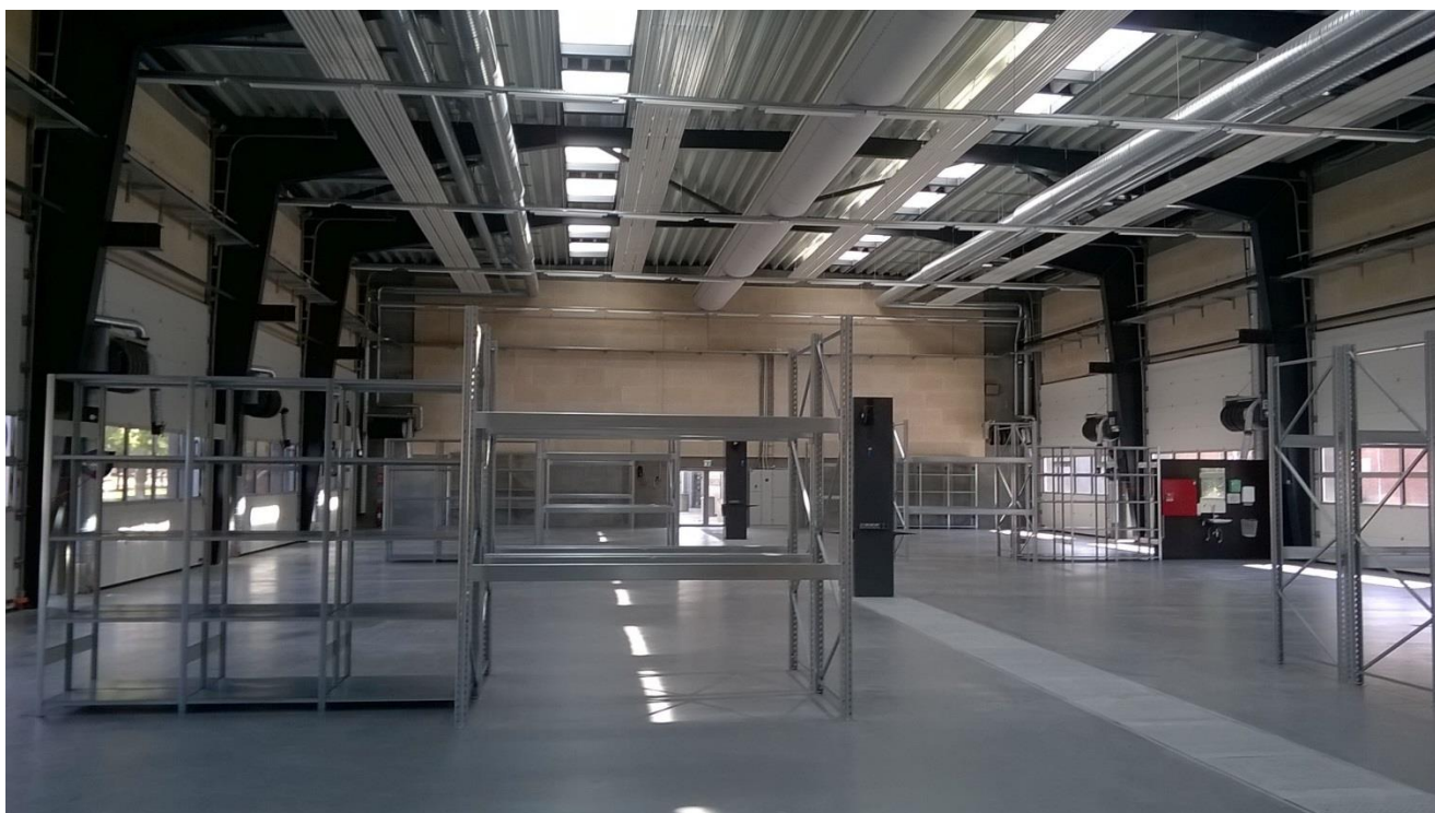
Høvelte Kaserne bygning 305. Opvarmet garage Foto: Forsvarsministeriets Ejendomsstyrelse
