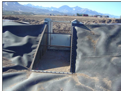
Figur 5.2: Skottet set fra Bassin 1. I baggrunden ses den forurenede jord i landfarmen og stationsområdet.
