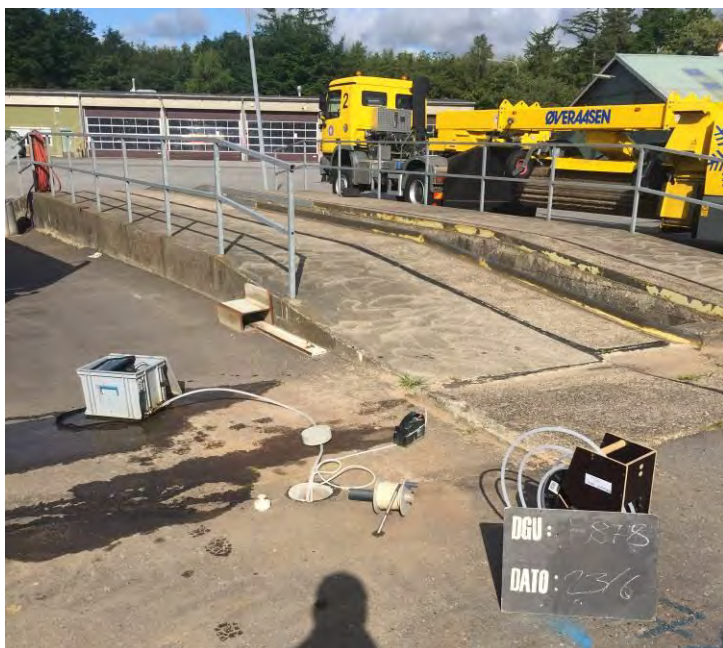
Foto 3: Boring B878 placeret ved vaskerampe ved Brand og Redning.
