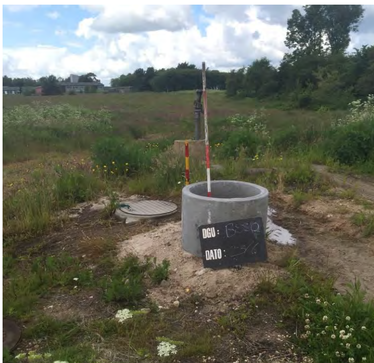
Foto 4: Boring B880 placeret ved olieudskiller OU38 der er tilknyttet den Ny Brandøvelsesplads.
