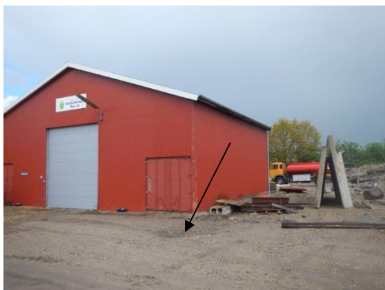
Foto 4: Øvelsesplads II. Bygning 210. Område, hvor der tidligere var et oliekar (kilde BRS342-141). Ved pilen anes et betondæksel, som vurderes tidligere at have været tilkoblet afløb på pladsen med oliekarret. Foto taget mod nord og mod bygning 210 /1/.
