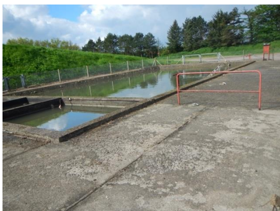
Foto 3: Øvelsesplads II. Bassin til opsamling af regn- og slukningsvand fra øvelsespladsen (kilde BRS342-170) med olieudskillere (kilde BRS342-135). Foto taget mod sydvest.
