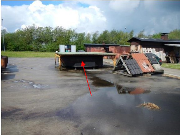
Foto 7: Brandøvelsesplads (BRS342-163) til brandøvelser med afløb til udskiller (BRS342-149). Der ses et oliekar under en overdækning (rød pil). Foto er taget mod vest.
