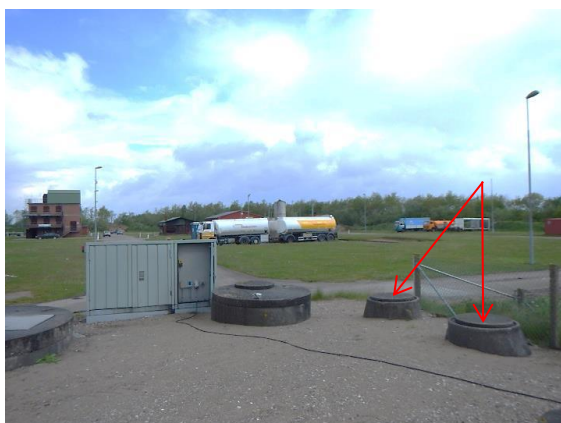
Foto 5: Øvelsesplads III. Olieudskiller (BRS342-155) tilkoblet afløb på øvelsespladsen.
