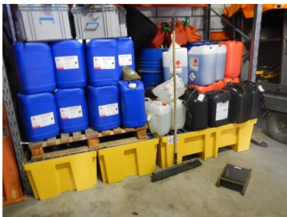
Foto 1: Bygning 104. Oplag af skumvæsker, benzin mv. på spildbakker (BRS341-120). Oplaget stod tidligere (før 2013) på betongulv uden spildbakker /1/.
