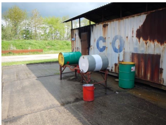
Foto 6: Olie-tønder med sprit til øvelsesbrug (BRS342-161). Tønderne er opstillet på en plads bestående af betonplader med revner og utætte samlinger. Foto er taget mod nord.
