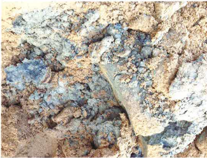
Billede 4 Taget under udgravning over tanke Sand med olieindhold. Olie er sort misfarvet gammel olie presset ud af tank
