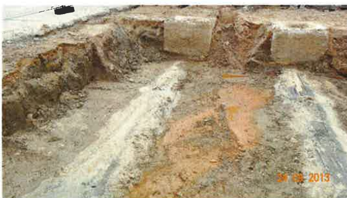
Billede 12 Frigravet og oprenset top af tankudgravning Betonstøbte nedgangsbrønde til mandehuller Ses øverst
