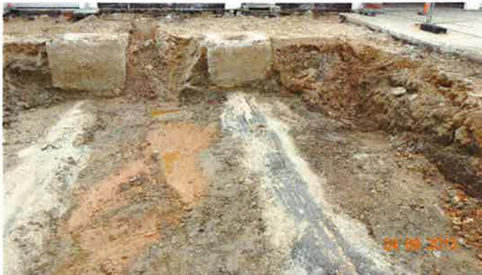
Billede 11 Frigravet og oprenset top af tankudgravning Betonstøbte nedgangsbrønde til mandehuller Ses øverst
