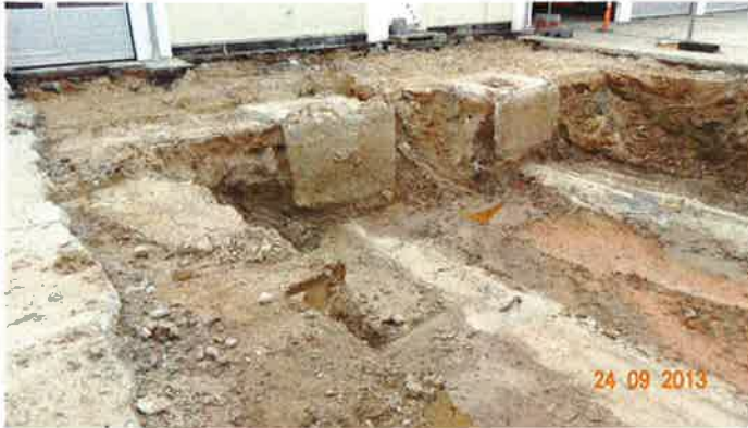
Billede 10 Frigravet og oprenset top af tankudgravning Betonstøbte nedgangsbrønde til mandehuller Ses øverst
