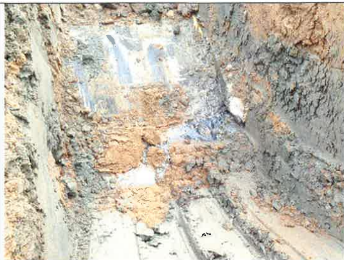
Billede 1 Taget under udgravning over tanke
