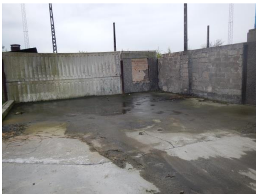
Foto 7: Betonbelagt område (BRS241-156), hvor der antændes oliekar, som slukkes med pulverslukkere. Foto er taget mod vest /1/.
