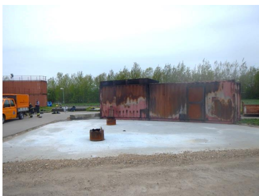
Foto 3: Plads til brug af pulverslukkere (BRS241-143). I baggrunden ses en overtændingscontainer. Foto er taget mod nord /1/.
