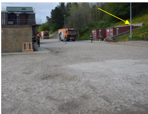
Foto 11: Ved den gule pil ses indgangen til bunker 1003/brandhus (kilde BRS240-158).
