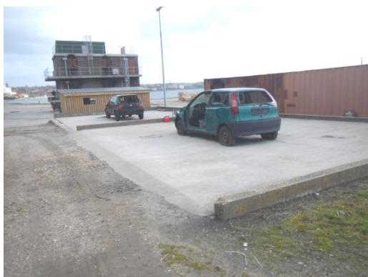
Foto 8: Betonbelagt brandøvelsesplads fra ca. 2000 (BRS240-151). Foto er taget mod nord.
