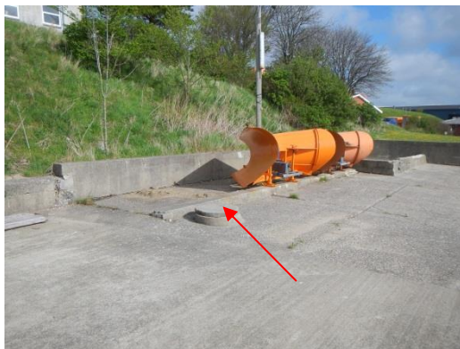
Foto 4: Rense- og oplagsplads (kilde 221-144), hvor der skulle være foretaget vask af brandslanger. Det er olieudskilleren (kilde 145), som ses midt i billedet (pil). Foto er taget mod nord.
