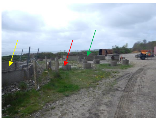
Foto 6: Spildevand fra det befæstede areal på øvelsespladsen ledes til et opsamlingsbassin (gul pil) videre til en olieudskiller (rød pil) og sidst til et rentvandsbassin (grøn pil) med overløb til fjorden. Foto er taget mod sydvest.
