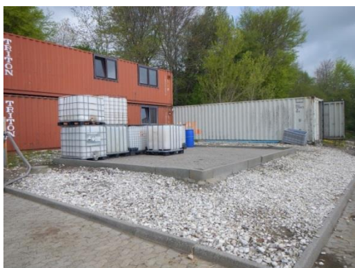
Foto 5: Brandøvelsesplads. Pladsen (kilde 147), hvor palletankene står opstillet, anvendes til brandøvelser med optænding i brandkar og med slukning med pulverslukkere. Foto er taget mod nord.
